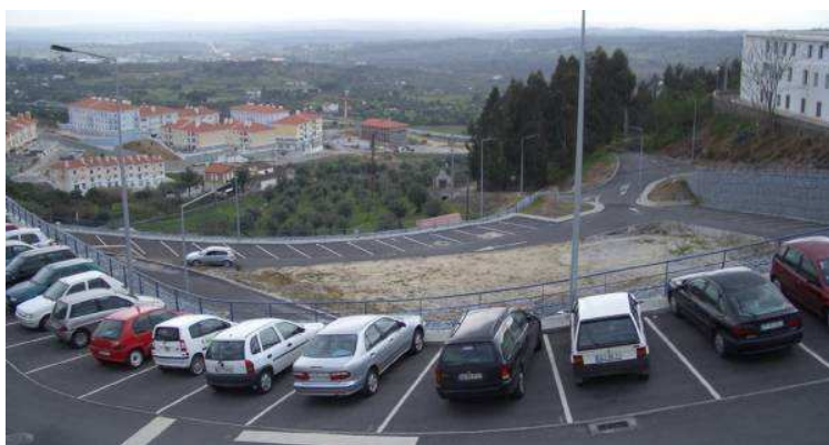
Vista Geral do Parque S. Pedro (de norte para sul)
